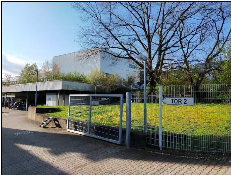
Abbildung 5: Südliches Gebäude Flst. Nr. 1599
