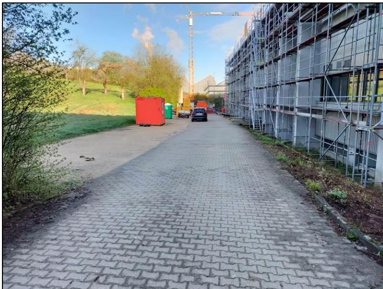
Abbildung 8: Fläche südlich des Gebäudes auf Flst. Nr. 1580
