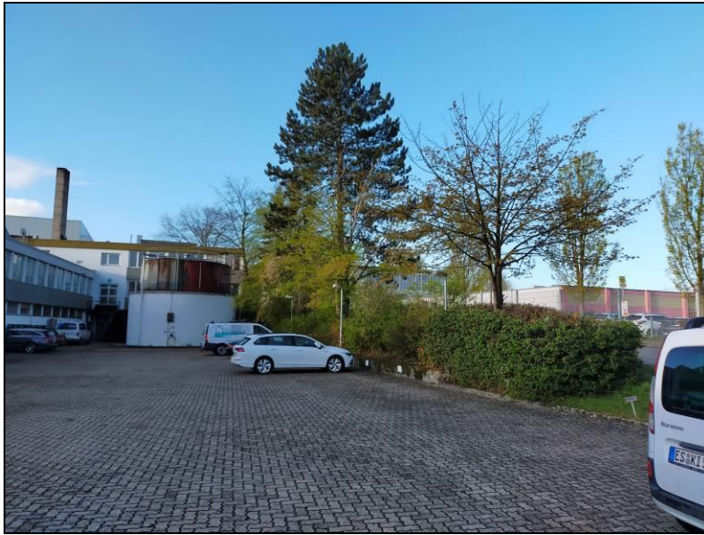
Abbildung 4: Nördliches Gebäude Flst. Nr. 1599
