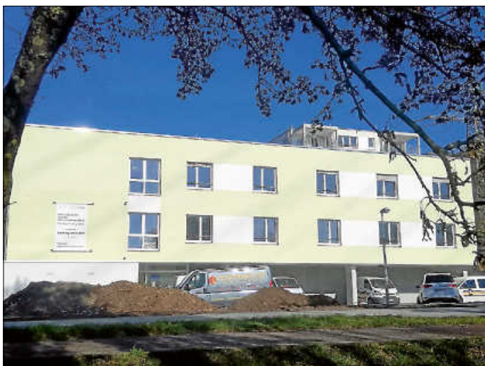
Das künftige Seniorenzentrum Altbach mit dem Cicely-Saunders-Zimmer (Mittlere Ebene, zweites Zimmer von links).
